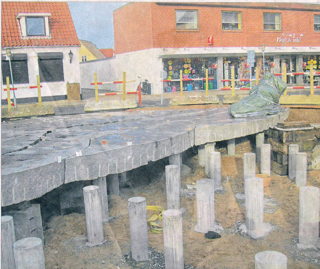
"Lille tektonisk Plads" under etablering. Bemærk de tykke granitplader, der ligger forskudt for hinanden. Foto: Preben Andreasen
