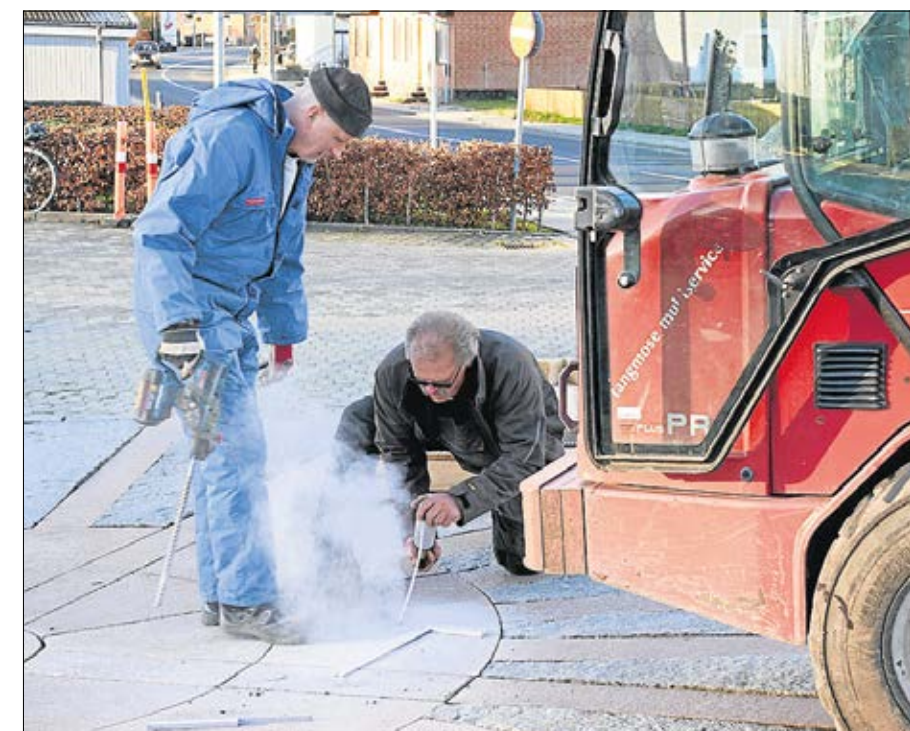
Claus Ørntoft borer monteringshuller, og Kjeld Nielsen blæser hullerne fri for støv. Foto: Niels Helver
