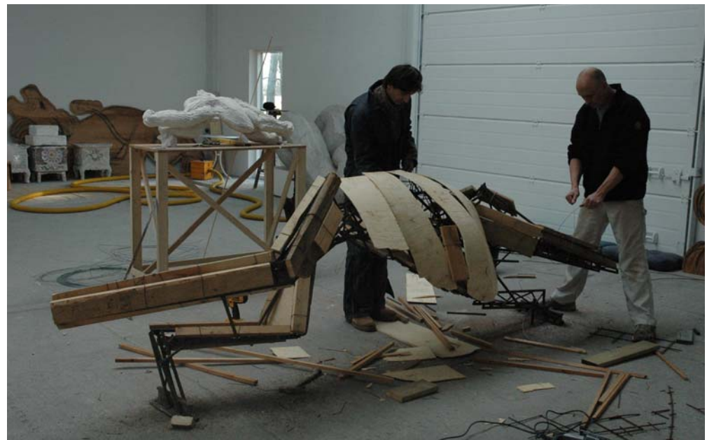
Træ påsættes armeringen for at undgå en massiv lermodel og reducere vægten
